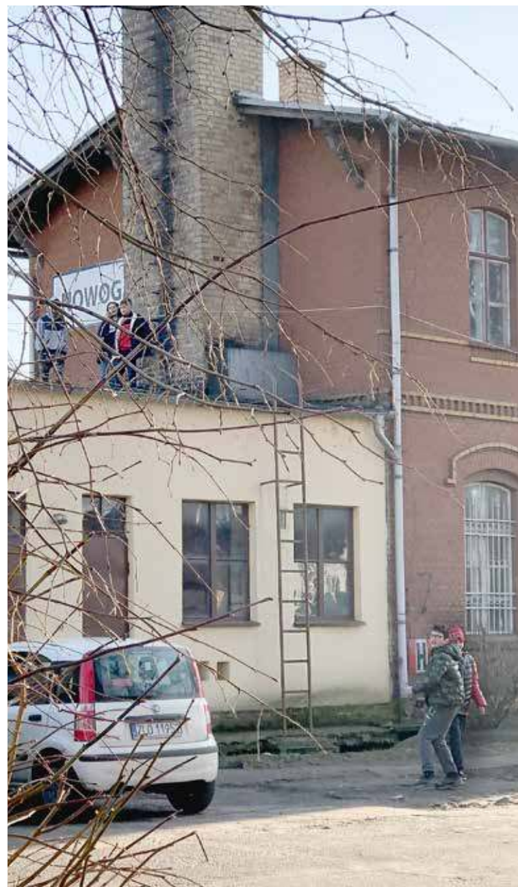
Na dach nowogardzkiego dworca można dostać się po widocznej drabinie
