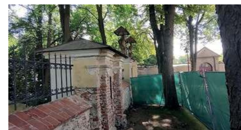
Remont fragmentu muru otaczającego klasztor w Alwerni
