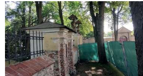
Remont fragmentu muru otaczającego klasztor w Alwerni
