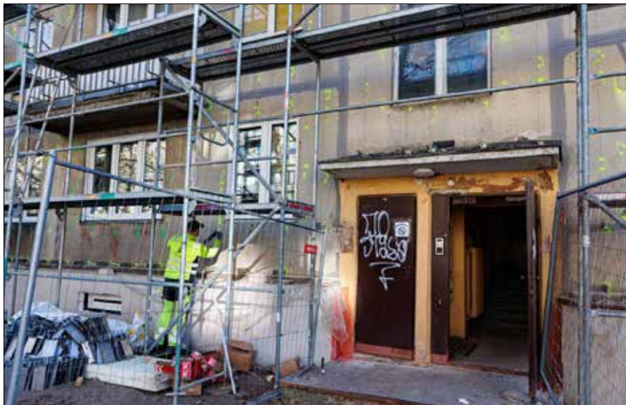
Realizacja renowacji w budynkach wielorodzinnych jest organizacyjnie wymagająca ze względu na dużą liczbę właścicieli Fot. Marian Paluszkiewicz
