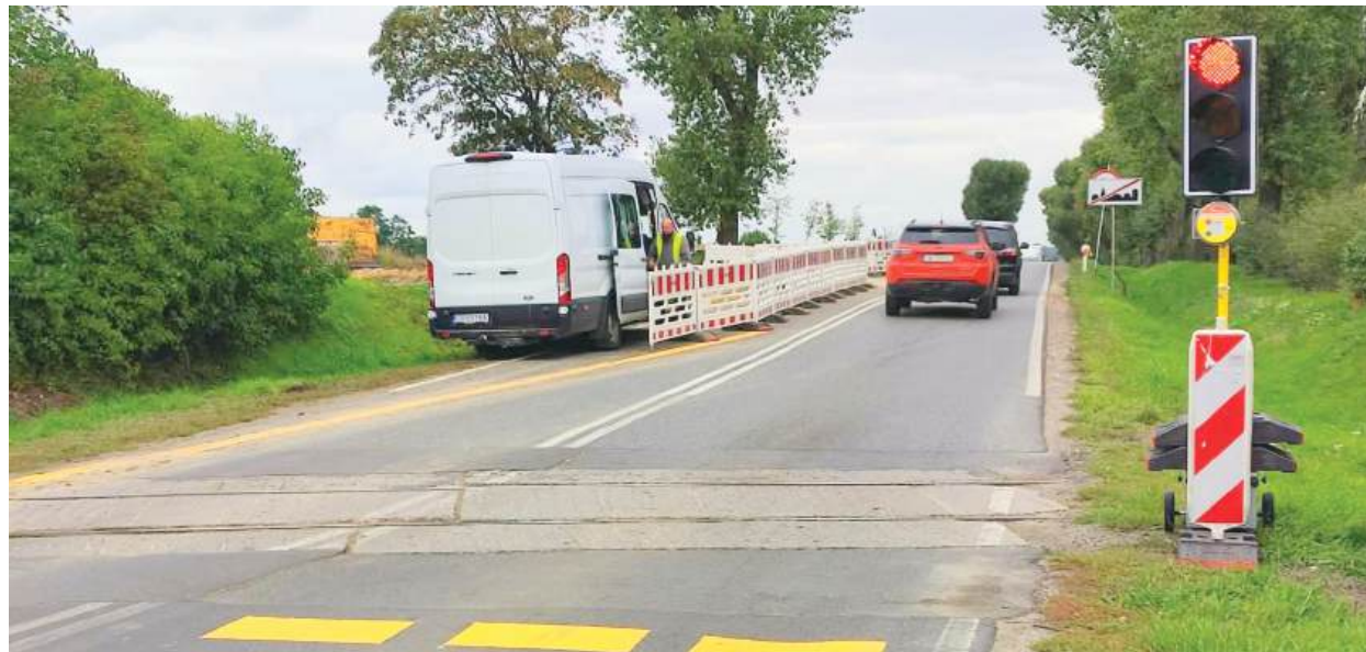
Od kilku dni na wjeździe do Strzelina od strony Wrocławia obowiązuje ruch wahadłowy z sygnalizacją świetlną
