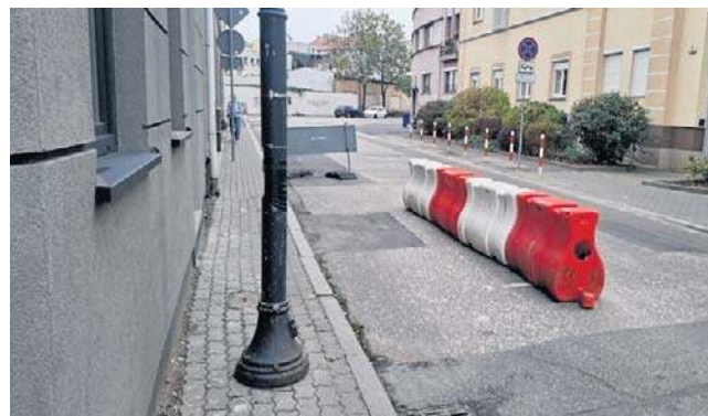
Być może jeszcze w 2025 roku rozpocznie się przebudowa chodnika na ulicy Świętej Trójcy w Bydgoszczy
