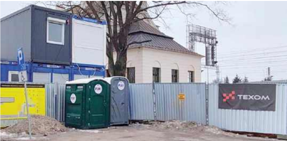
Zgodnie z informacją PKP w czasie trwania prac przy dworcu wykonawca ma obowiązek zapewnić jedynie tymczasowe obiekty sanitarne dla podróżnych, a nie poczekalnię. Na zdjęciu ustawione przy stacji w Łukowie toalety przenośne
