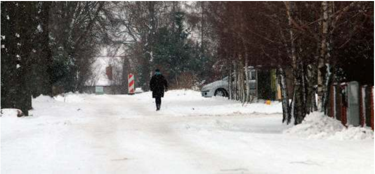
Ulica Gospodarcza wciąż czeka na betonową nawierzchnię
