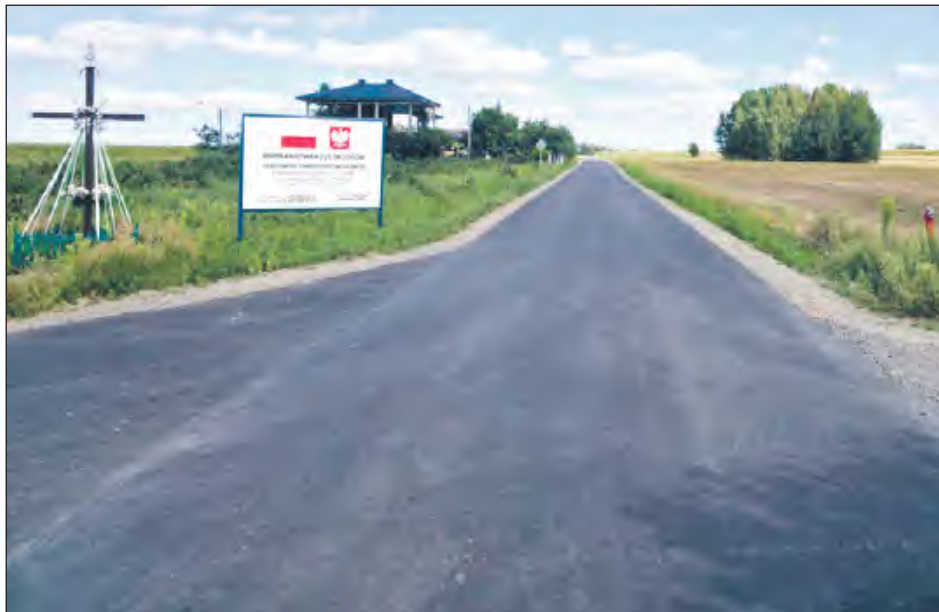
Efekt przeprowadzonego zadania, to modernizacja asfaltowej nawierzchni jezdni i przebudowa poboczy ziemnych na pobocza z kruszywem
