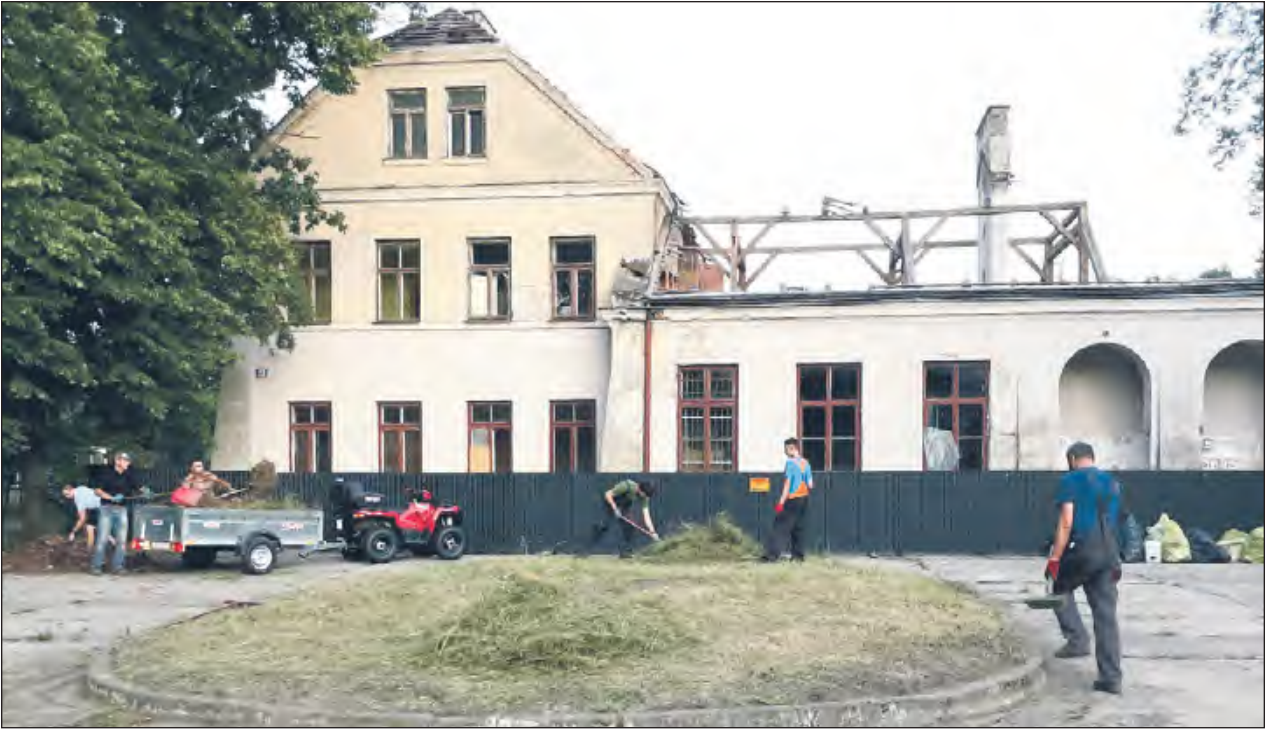
Wybudowany w 1924 roku obiekt został wyłączony z użytkowania przez PKP w pierwszej połowie lat 90. Od tego czasu popadał w coraz większą ruinę, ale mieszkańcy wierzą, że wróci do dawnej świetności. Zanim to nastąpi na początek postanowili uporządkować teren wokół dworca (fot. Inicjatywa Dworzec Leopoldów/Facebook)
