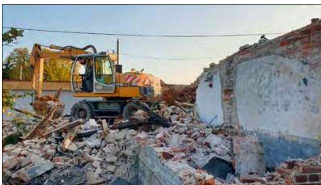
Prace rozbiórkowe ruszyły 15 października.
