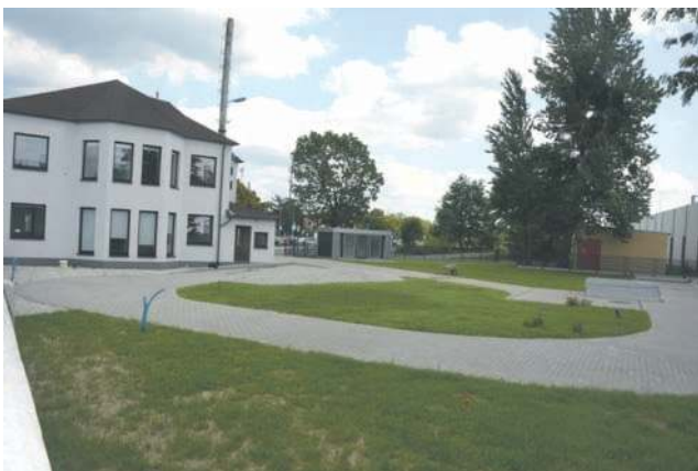
Plac manewrowy jest już prawie gotowy
