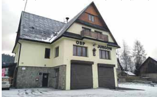
Budynek ochotniczej straży ma m.in. nowe okna, ocieplenie, przebudowaną kotłownię.
