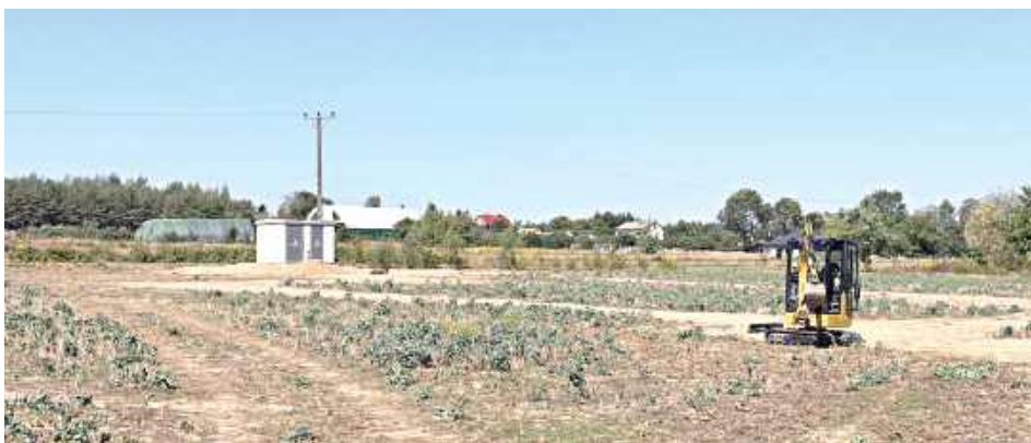
W tym miejscu powstaną bloki SIM. Początek prac ziemnych Fot. Artur Toruń
