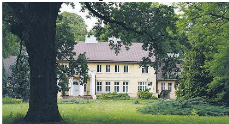
Pałacyk po DPS w Chojnie Nowym Pierwszym od kilku miesięcy jest już pusty. Spadkobiercy nie kwapią się do przejęcia. Zmarnieje jak kilka innych zabytkowych budynków w okolicy?
