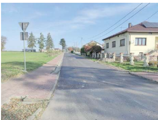
Nowy chodnik o długości około 3 kilometrów zostanie wybudowany na odcinku Obsza - Zamch
