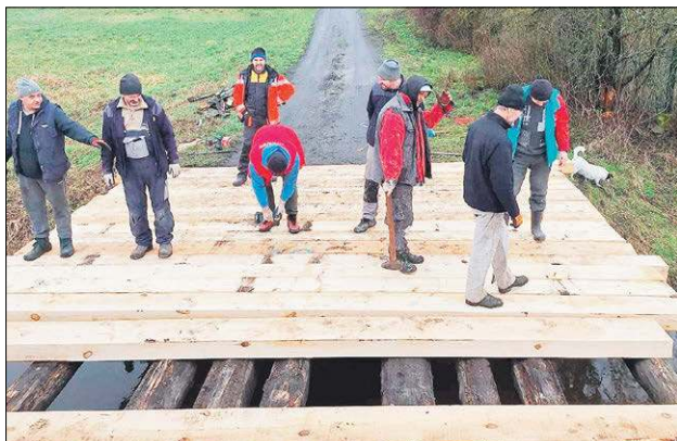
Mieszkańcy Romaszek zebraли się i wymienili nawierzchnię mostu, nie naruszając jego podstawy
