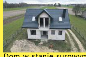
Dom w stanie surowym otwartym, Wólka Siemieńska, 885 851 160
