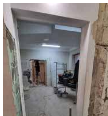
Trwają prace remontowe w pomieszczeniach RTG w szpitalu, aby dostosować je do nowych standardów
