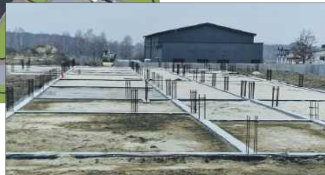
Aktualnie gotowe są fundamenty pod budowę nowej placówki.
