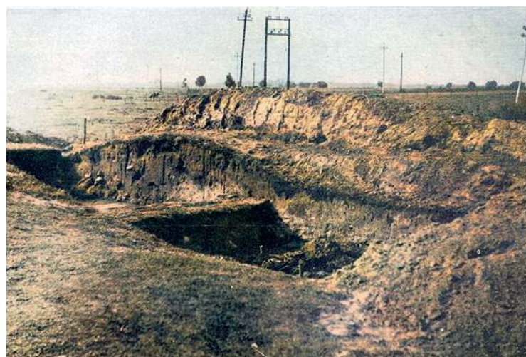
Wał grodziska, wykop, lata 60.
