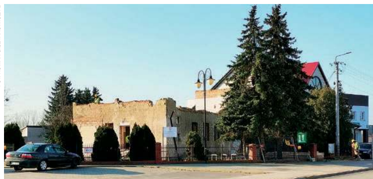
W ubiegłym tygodniu wznowiono prace przy przebudowie Urzędu Gminy w Sypniewie.
