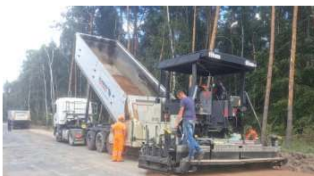
Zainwestowaliśmy 30 milionów zł w remonty dróg powiatowych na terenie gminy Radzyń Podlaski
