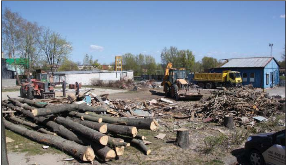
✚ Trwa przygotowanie placu pod budowę. Roboty zaczęły się od wycinki drzew i krzewów
