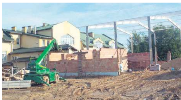
Budowa ma się zakończyć w październiku 2022. Fot. UG Zamość
