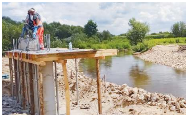
Budowa mostu w Kuclach
