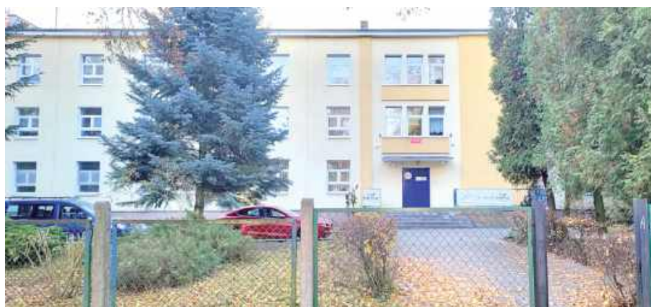
Ten budynek bursy miał zostać wyłączony na rok z użytkowania ze względu na remont. I właśnie m.in. tym dyrektor uzasadniał rozwiązanie stosunku pracy z wychowawcami
