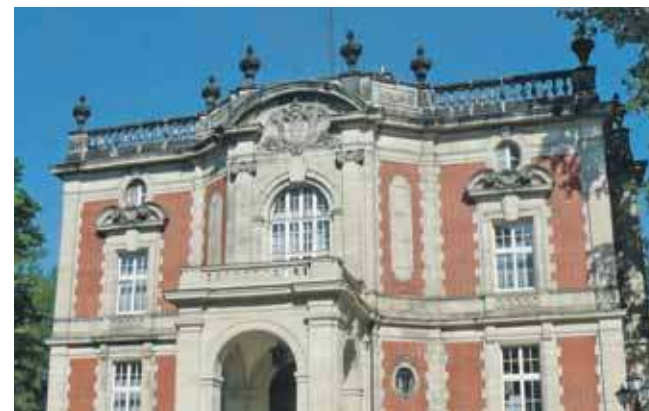
Dach zabytkowego Pałacu Kawalera w Świerklańcu ma iść do remontu
