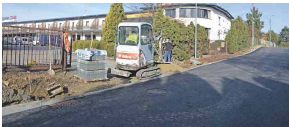
Trwa m.in. układanie chodników
