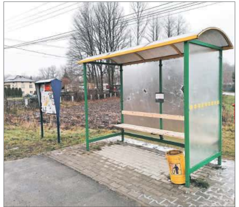
Taki widok pozostawiają po sobie wandale.
