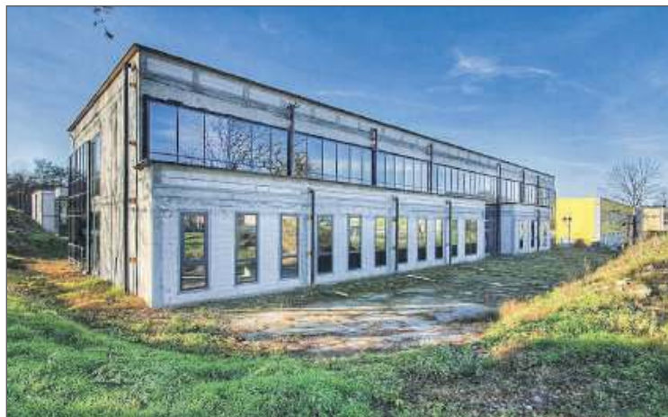
Pieniądze trafią m.in. na dalsze prace przy budowie szkoły. Fot. Starostwo Powiatowe w Dębicy.
