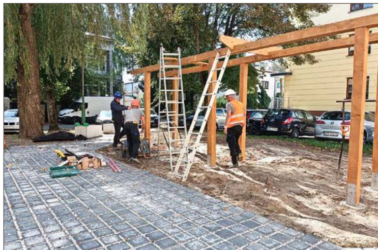
Na Batorego prace budowlane dobiegają końca.
