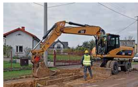
Budowa sieci kanalizacyjnej ul. Białowiejska
