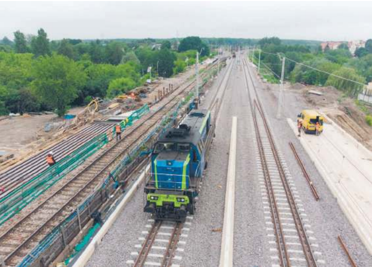
Przed tygodniem ponad 115 tonowa lokomotywa przeprowadziła tzw. próbę obciążeniową, przebudowywanego wiaduktu kolejowego nad ulicą Janowską. Próba wypadła pomyślnie
