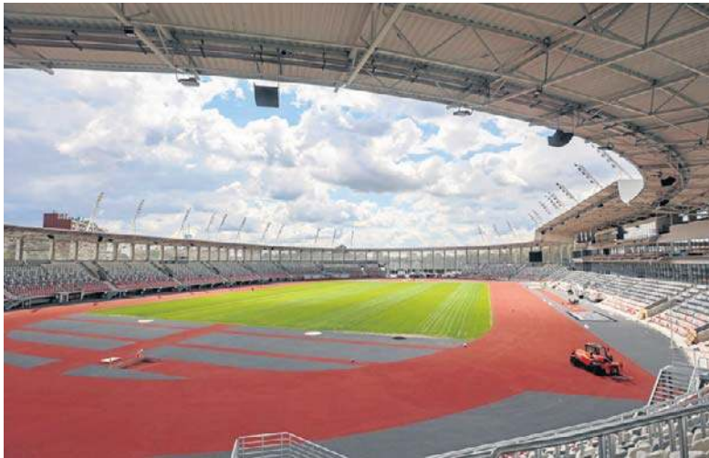
Na zadaszonych miejscach siedzących stadion pomieści 8 tysięcy widzów
