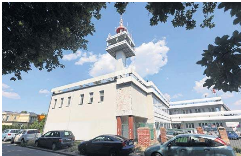
W miejsce wieży ma stanąć 10-piętrowy budynek kaskadowy.
