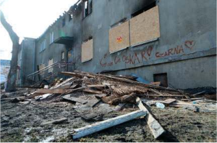
Pożar zamienił budynek w ruinę
