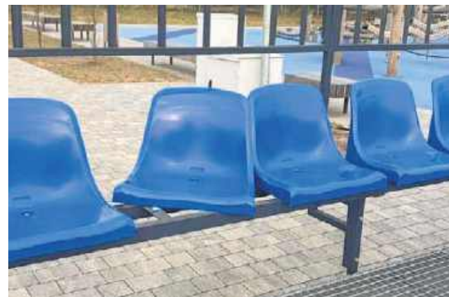
OSiR odnotowuje powtarzające się przypadki uszkodzeń siedzisk na trybunach
