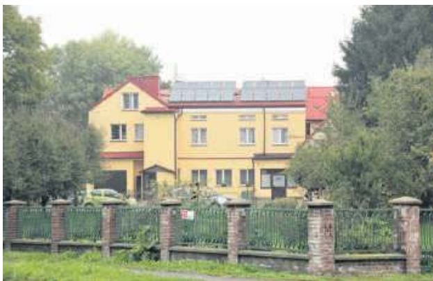
Dom Pomocy Społecznej przy ul. Żdanowskiej.
