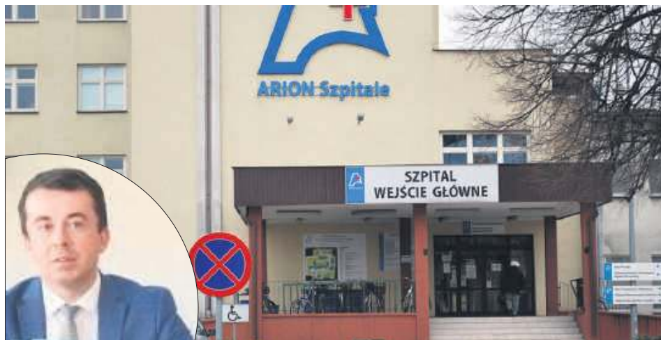
Andrzej Szarlip: Trwa postępowanie upadłościowe spółki, ale zarząd powiatu podejmuje równoległe inne działania mające na celu odzyskanie szpitala.
