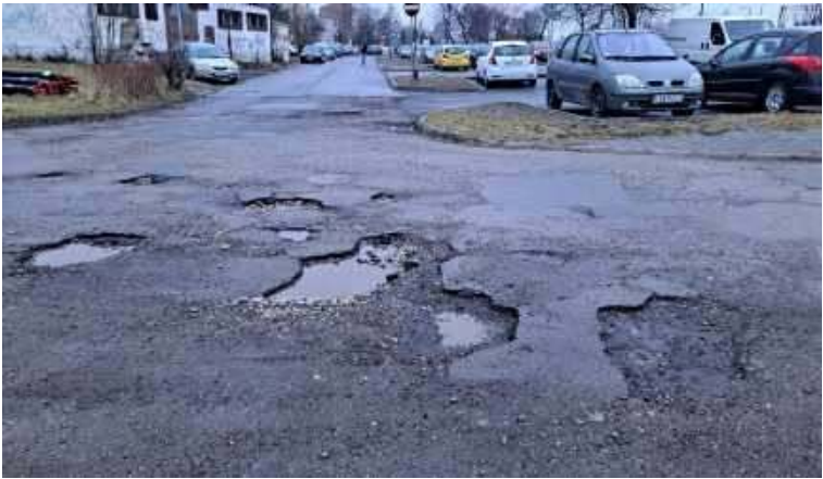
Prace drogowe na ul. Witosa jeszcze nie ruszyły, ale Ratusz uspokaja, że niebawem się to zmieni i termin zakończenia inwestycji, zaplanowany na jesień tego roku, na pewno będzie dotrzymany
