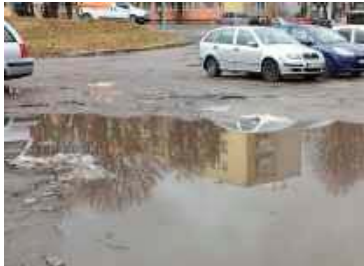
Olbrzymie kałuże, które tworzą się wzdłuż budynku przy ul. Kosynierów 10 są utrapieniem klientów sklepów „Ziarenko” i „Premium”
