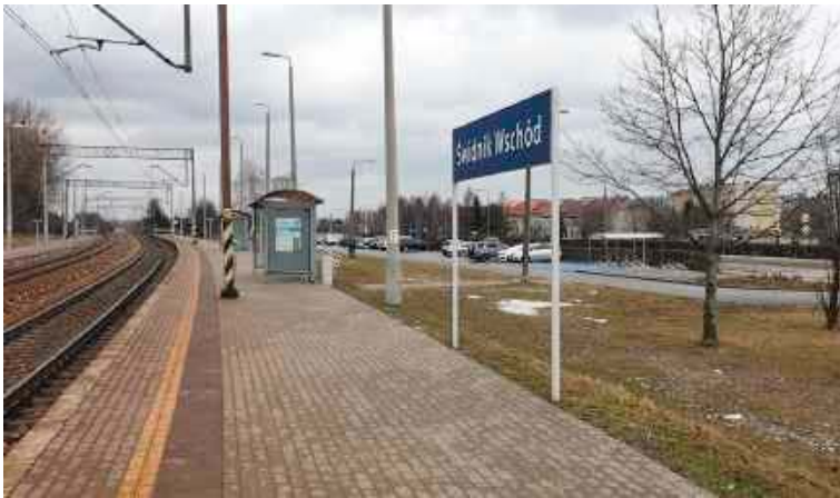
Ustawienie wzdłuż torów, na wysokości stacji Świdnik Wschód, ekranów akustycznych poprawiłoby komfort życia mieszkańców pobliskich bloków i domów
