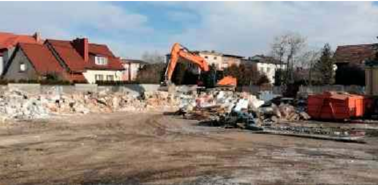
Inwestycja rozpoczęła się od wyburzenia starych magazynów PSZOK
