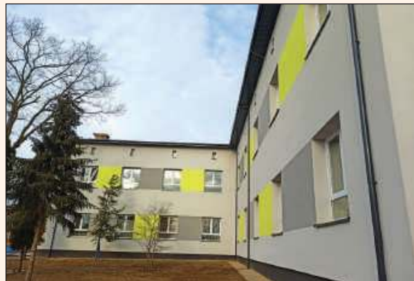
Szkoła Podst. w Bazanowie po termomodernizacji
