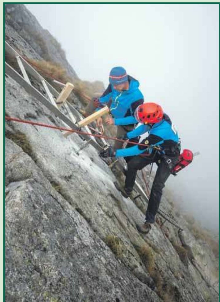
Montaż górnego odcinka nowej drabinki.
