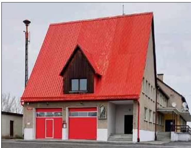
Po remoncie budynek będzie zużywał mniej energii.
