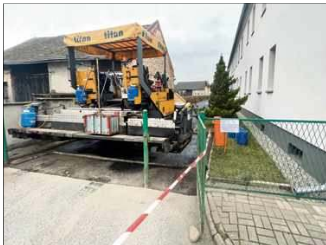
Na placu powstaje zupełnie nowa nawierzchnia asfaltowa.
