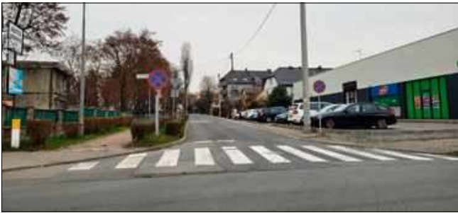
Na początek ma powstać tutaj prawoskręt. To udroźni ruch.
