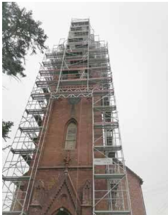
Remontowana jest wieża kościoła w Żarnowie (fot. Gm. Stepnica)
