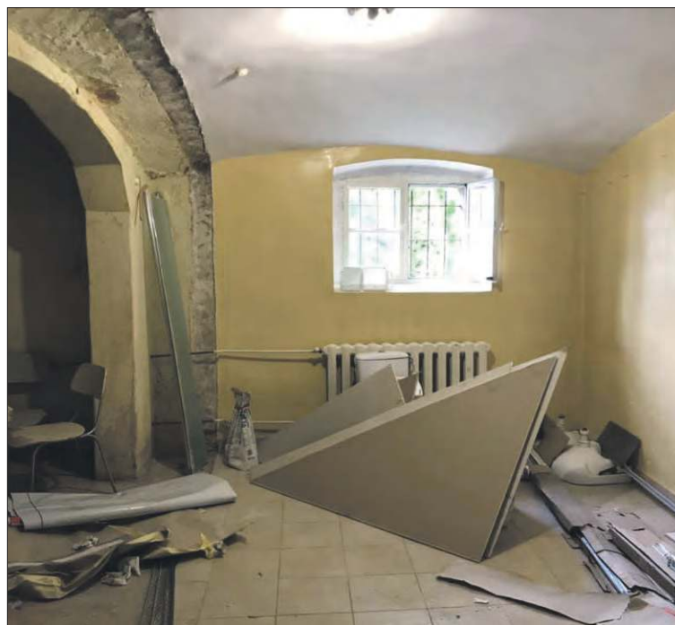
Pomieszczenie szpitalne wkrótce zostanie zagospodarowane
