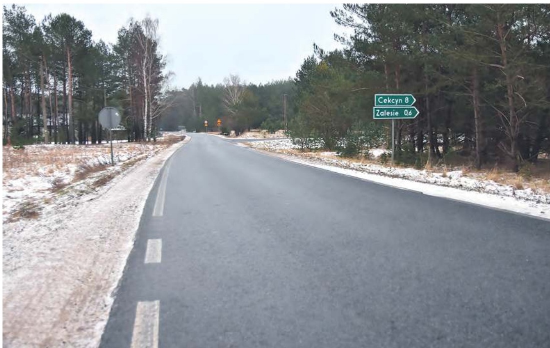
Napoleonka zostanie przebudowana na odcinku 11 km i 250 metrów. Prace rozpoczną się w okolicach Okierska i będą prowadzone w kierunku Tlenia. Jezdnia zostanie poszerzona do 6 metrów.
