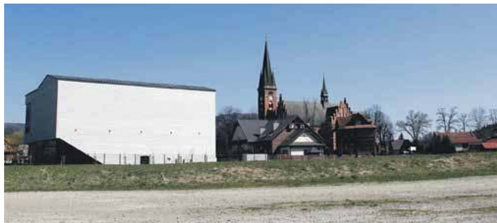
Tu ma powstać nowy obiekt handlowy.
