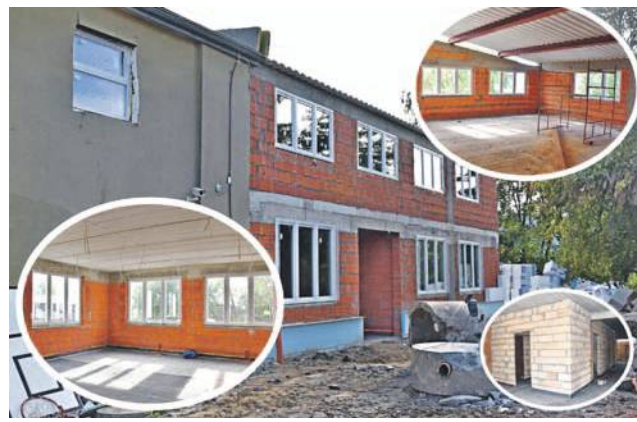
Byliśmy w środku nowo wybudowanej dwukondygnacyjnej części sali gimnastycznej z przeznaczeniem na sale dydaktyczne.
