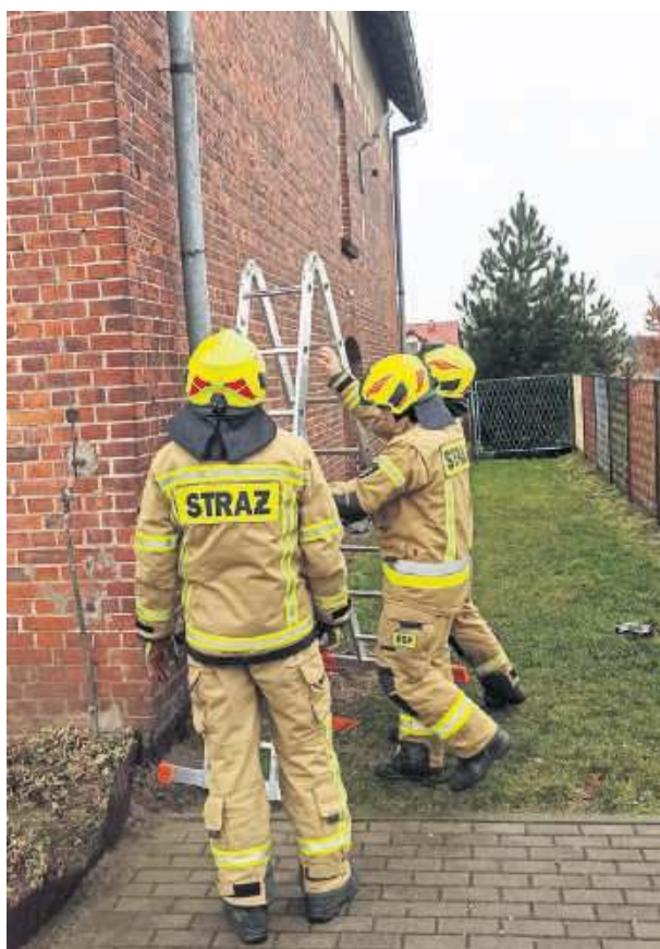
Strażacy zabezpieczali rynny na budynku Szkoły Podstawowej w Kuropatniku
