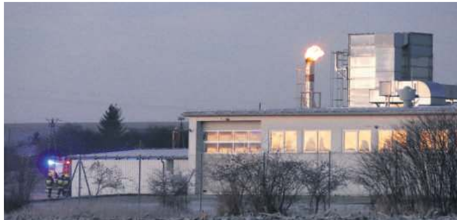
W niedzielę, 16 stycznia, o godz. 6.45 mieszkańcy Przeworna powiadomili straż pożarną, że z komina kotłowni zakładu Kessler wydobywa się ogień
