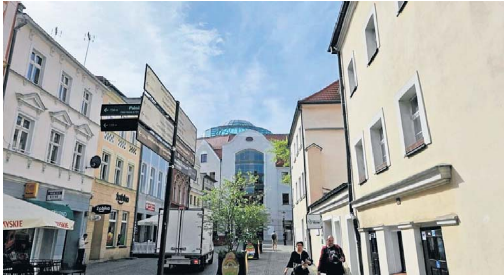
Właściciel uznał, że warto zainwestować w Złoty Dom. Wysprzątał teren, naprawił dach, kopuła też jest już szczelna
