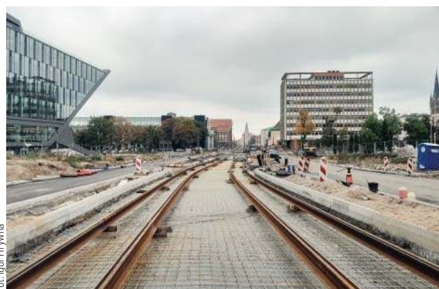
Na Piłsudskiego widać już nowe tory
