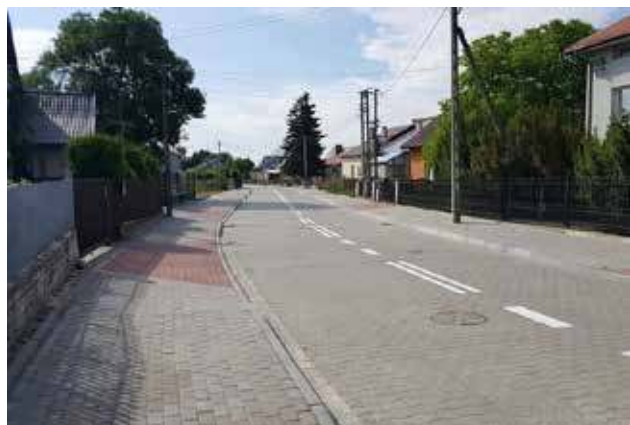
Ulica Gliniana w Mordach po remoncie
