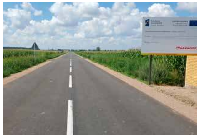
Przebudowana droga powiatowa Zbuczyn – Tchórzew – Izdebki-Kosny
