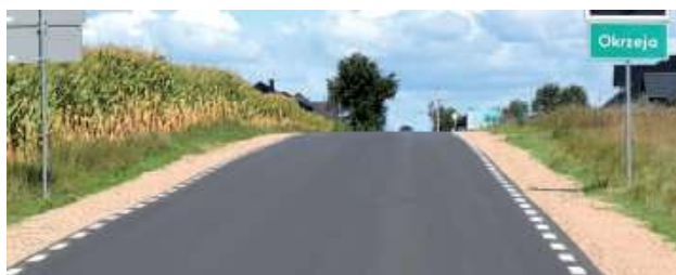
Wykonawcą prac wyłonionym w trakcie postępowania przetargowego było Przedsiębiorstwo Robót Inżynieryjno - Drogowych S.A. w Łukowie
