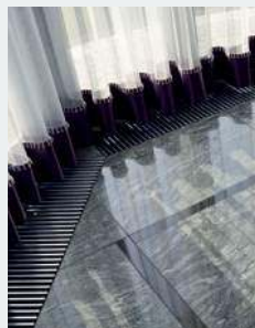
🔧 Grzejniki kanałowe zamontowano pod oknami tarasowymi.
