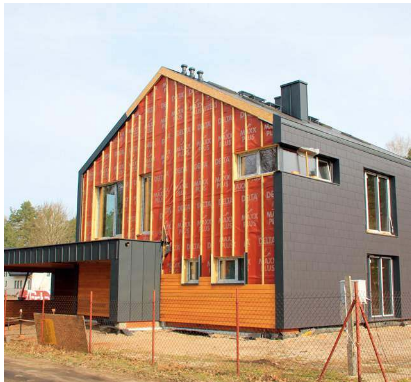
📍 Różne elewacje na różnych ścianach – drewniana oblicówka i płytka włókno-cementowa, schodząca z dachu na mur. J. WERNER
