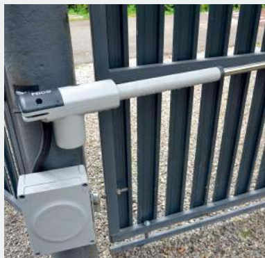
❶ Do słupka siłownik teleskopowy przy-spawano, do skrzydła – przykręcono śrubami.
