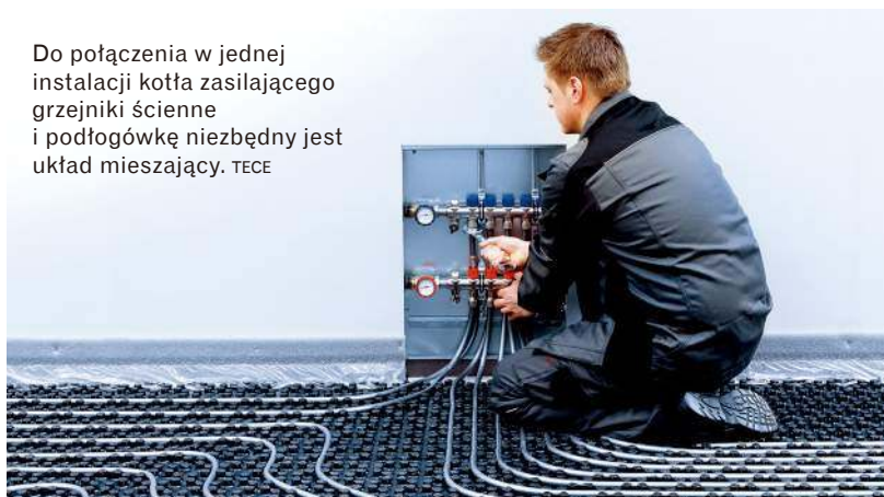
🔗 Urządzenia kondensacyjne efektywnie pracują połączone zarówno z niskotemperaturową instalacją ogrzewania podłogowego (a IMMERGAS), jak i z grzejnikami ściennymi (b LUXRAD).
