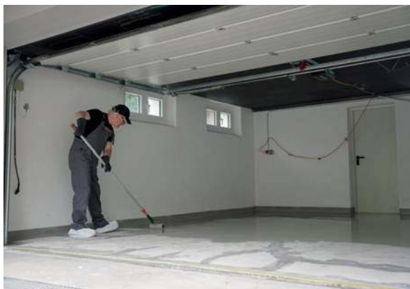
🔧 Bramę garażową zakłada się w wykończonym wnętrzu, na gotowej posadzce. SCHOMBURG
