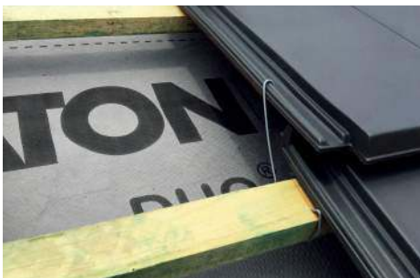
🔧 Kolejne etapy układania dachówek. CREATON POLSKA
