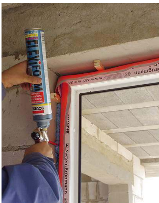
🔊 W montażu warstwowym pianę zabezpiecza się z zewnątrz i od środka specjalnymi taśmami. Soudal
