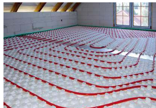
Wodne ogrzewanie podłogowe układa w grubej warstwie jastrychu lub mocuje do płyt systemowych, z lekkim pokryciem z suchego jastrychu. PIPELIFE, KNAUF
