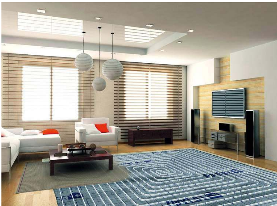
🔹 Pompa ciepła jest najskuteczniejsza wtedy, gdy temperatura w obiegu źródła górnego nie jest zbyt wysoka. Dlatego najlepiej sprawdza się w duecie z ogrzewaniem płaszczyznowym. PIPELIFE
