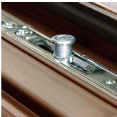
🔧 Im więcej rolek ryglujących na obwodzie okna, tym trudniej je wyważyć. MS WIĘCEJ NIŻ OKNA
