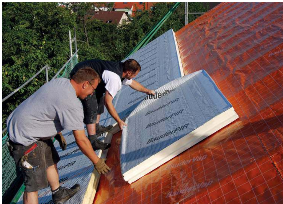
🔧 Izolacja nakrokwiowa z płyt z piany PIR. BAUDER
