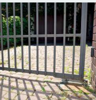
❶ W gruncie, przy dwuskrzydłowej bramie, zagłębiono elementy napędu.
