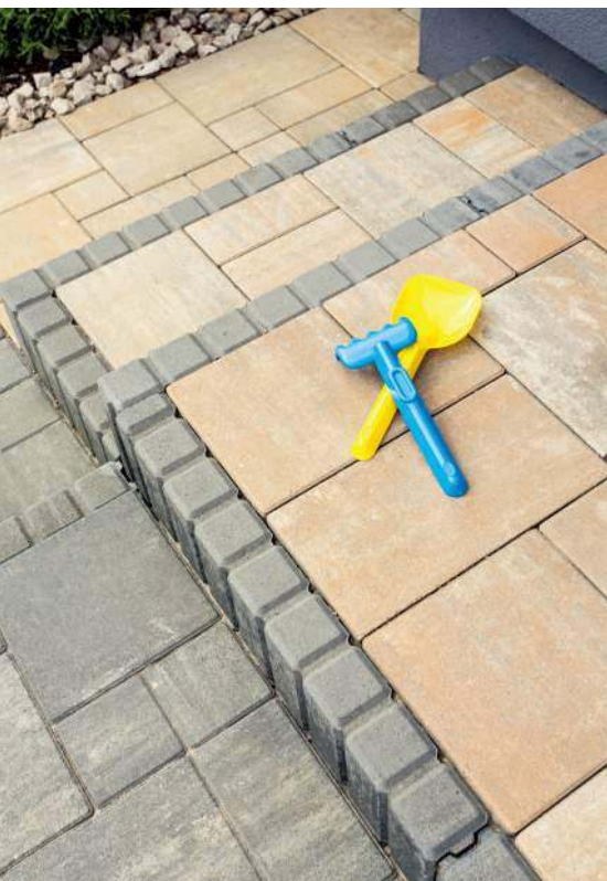
❶ Sposób wykonania tarasu na gruncie wykończonego kostką betonową.
