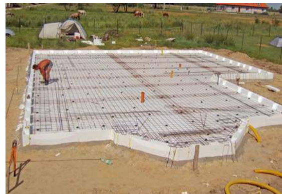
🔧 Płytę fundamentową ociepla się nie tylko z boków, ale i od dołu. LEGAETT
