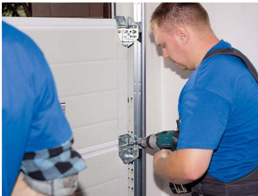
🔧 W modelach segmentowych rolki mocuje się do każdego panelu. NOVOFERM
