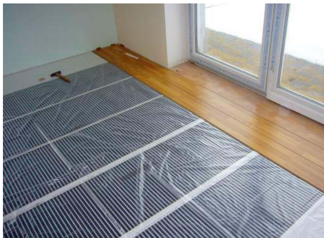
Na elektryczną folię grzewczą można ułożyć niektóre panele podłogowe. FENIX POLSKA
