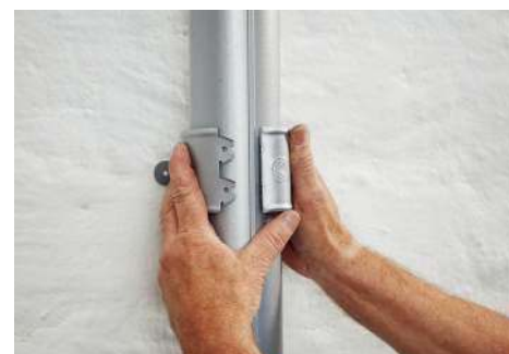
Kolejne etapy montażu orynnowania. BLACHY PRUSZYŃSKI, LINDAB
