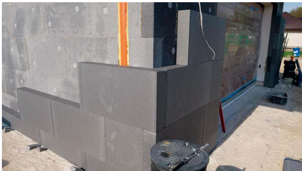
📍 Tak ociepla się ściany domów energooszczędnych – podwójna warstwa płyt z grafitowego styropianu, układanych na mijankę. A. PAPLIŃSKI
