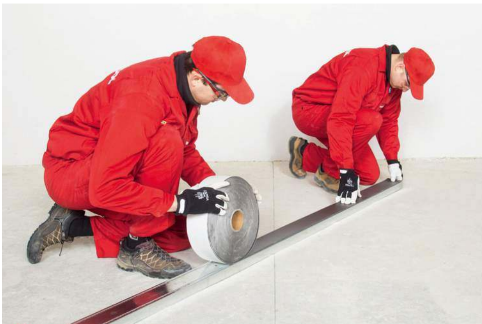
🔗 Elementy stelaża podkleja się taśmą wygłuszającą, która eliminuje drgania. Tak przygotowane panele mocuje się do podłogi, ścian i sufitu. rockwool
