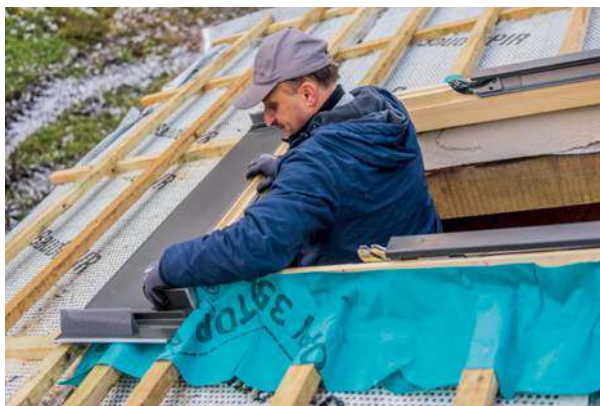
🔧 Kołnierz uszczelniający z fartuchem elastycznym to elementy, które odróżniają okno dachowe od fasadowego. FAKRO
