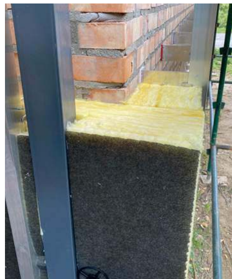
📍 Ściana ocieplona wełną mineralną. URS
