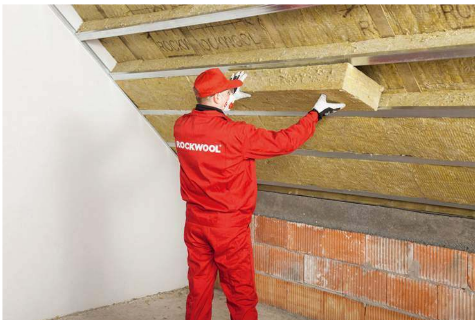
🔧 Wełnę na połaci dachu skośnego układa się w dwóch warstwach. ROCKWOOL
