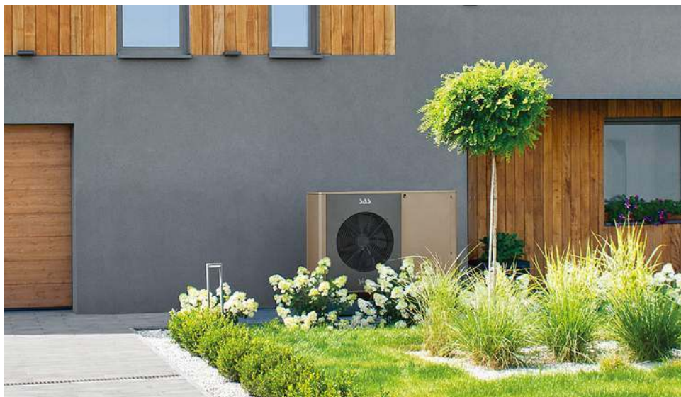
Pompy ciepła różnią się od siebie mocą. W dobrze zaizolowanym budynku z reguły wystarcza urządzenie o mocy nominalnej ok. 10 kW. SAS, SYSTHERM
