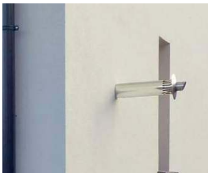
🔗 Zasada działania koncentrycznego przewodu powietrzno-spalinowego.
