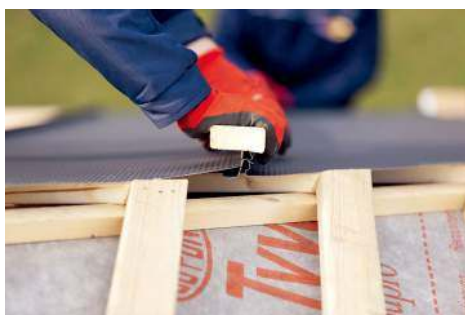
Kolejne etapy układania blachy płaskiej na rąbek stojący. BLACHY PRUSZYŃSKI
