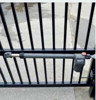
Siłowniki (proste) przytwierdzono do obu skrzydeł bramy.
