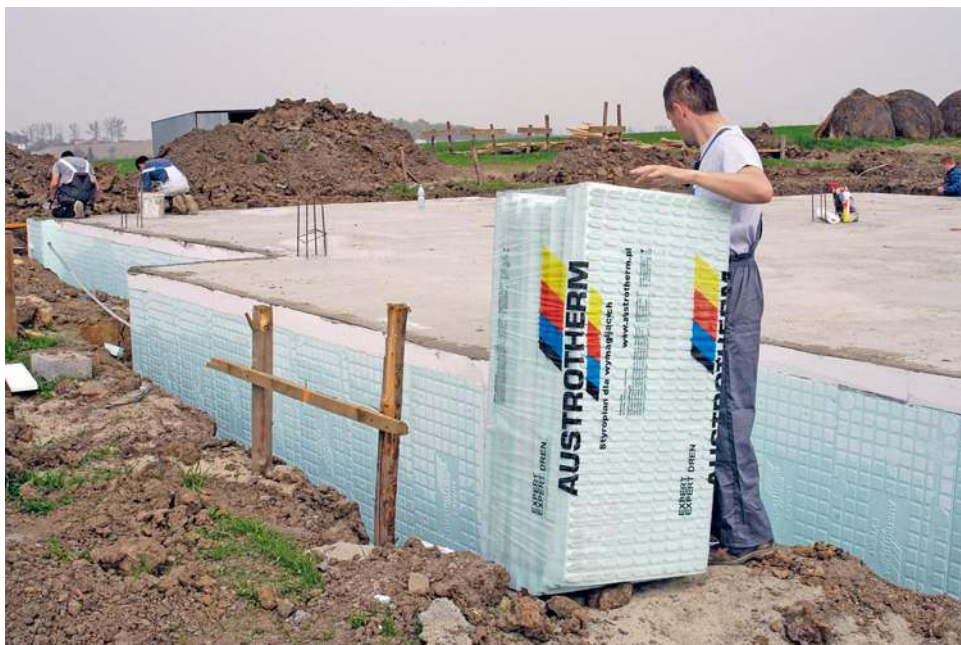
Do termoizolacji ścian fundamentowych przeznaczony jest styropian odporny na zawilgocenie, który zwykle jest niebieski. AUSTROTHERM
