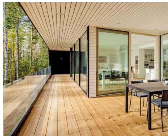
📍 Taras z nawierzchnią z drewna termowanego jest odporny na biodegradację i wycieki żywicy. JAF POLSKA
