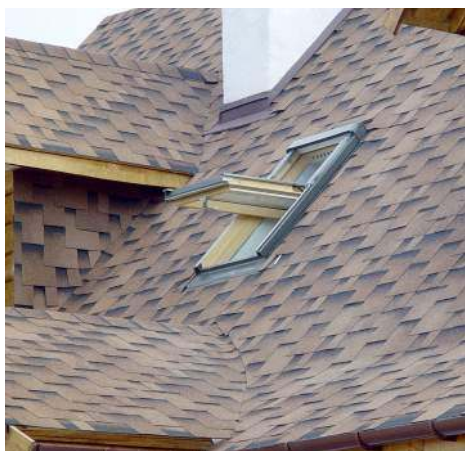
🔗 Gonty bitumiczne można układać na dachach o praktycznie dowolnym kącie nachylenia. STEMA
