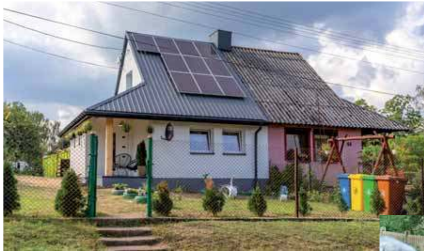
Remont części domu, należącej do pani Agnieszki, trwał dokładnie 5,5 dnia
