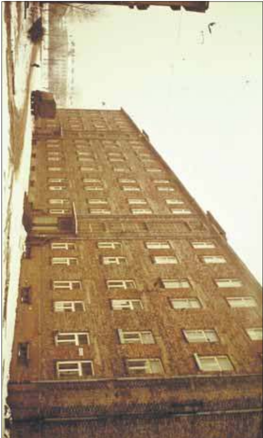
Archivalne zdjęcie jednego z budynków obozowych (więziennych) – (MMU)
