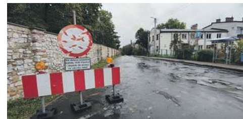
Ulica Dworska w Chrzanowie
