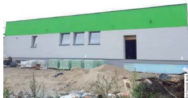
Prace nad budową supermarketu wciąż trwają. Z nieoficjalnych informacji wynika, że zostanie otwarty jeszcze w tym roku
